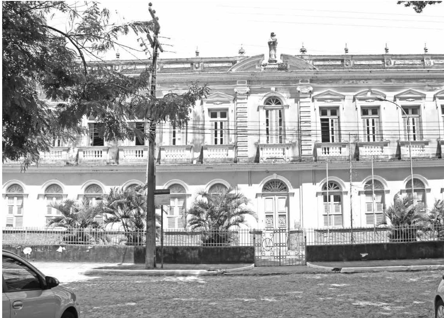
O prédio do antigo Colégio Nossa Senhora das Neves, que será a sede do parque, está passando por uma reforma e restauração
